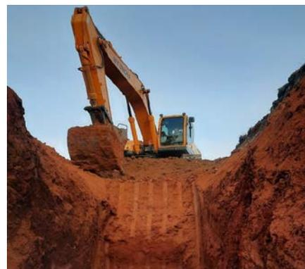
Проходка разведочных канав производится двумя японскими экскаваторами Takeuchi-TB-175
